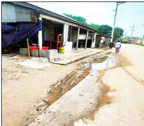
Drain-4, Kaliakair Pourashava
