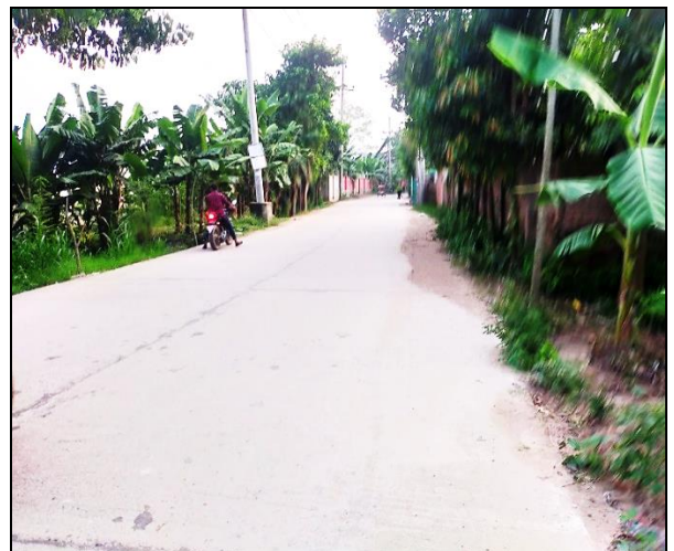
Drain-4, Kaliakair Pourashava
